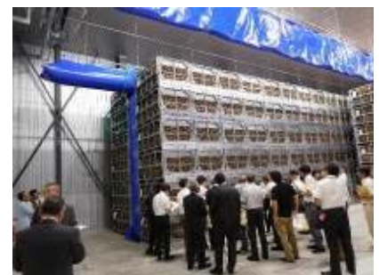
たまねぎ乾燥冷蔵施設内部（あわじ市）
