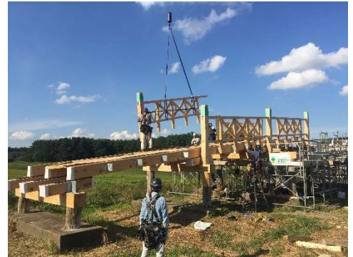
鶴の舞橋 改修工事の様子
