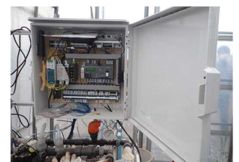
施設園芸の自動かん水・施肥装置
