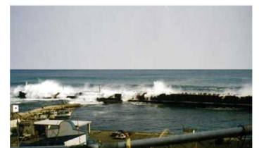
防波堤からの越波
