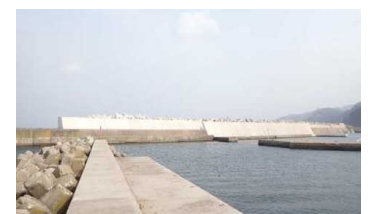
防波堤の高上げ
