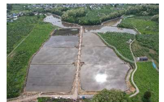
基盤整備後の水田(猿沢地区)
