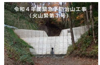
計画的な治山施設の整備
