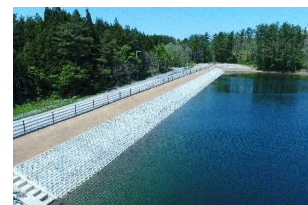
改修を終えた防災重点農業用ため池 (太郎須田ため池)
