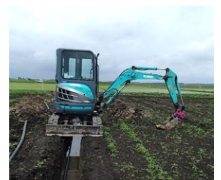
暗きょの補修作業
