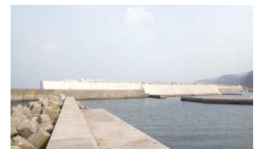
防波堤の高上げ
