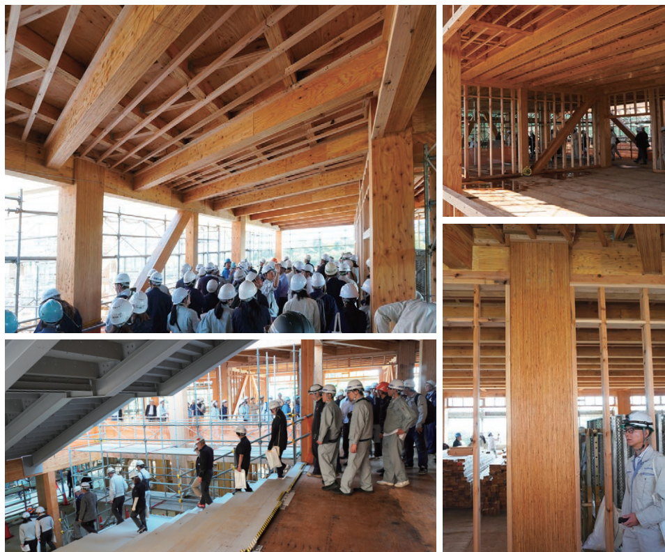
2024年6月の構造躯体見学会の様子。大きな柱の前や梁がめぐらされた天井の下で担当者による説明が行われた。
