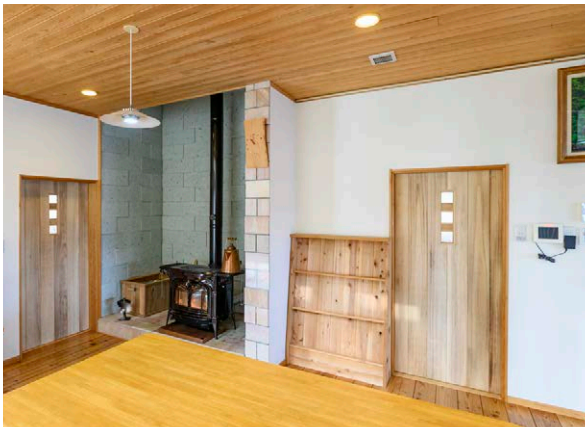
リビングの一角に、家全体を暖める薪ストーブを設置。 遠赤外線放射機能を持つ十和田石を周囲の壁材に採用し、効果を高めている。
