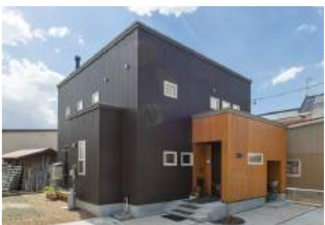
黒をベースにした外観。玄関部分にスギを使い、メリハリをつけた。
