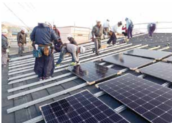
太陽光発電の設置を学ぶ板金屋実地研修会の様子
