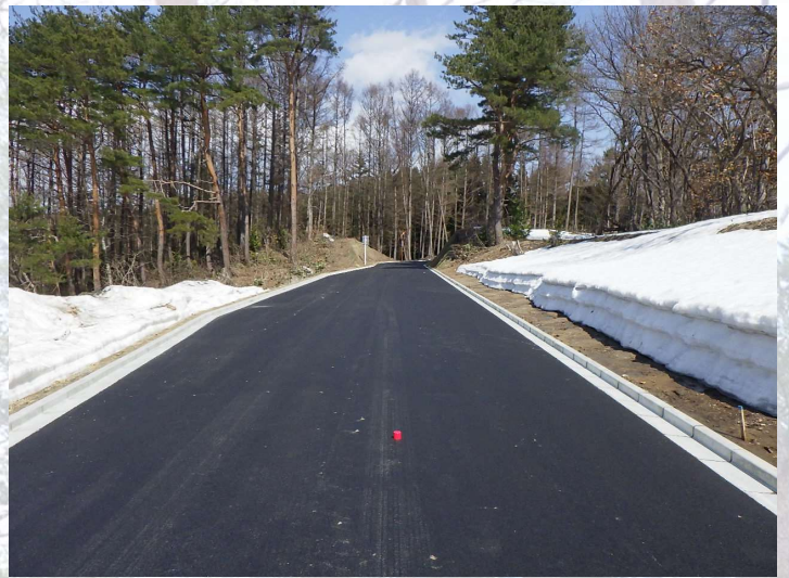
林道作設工事
