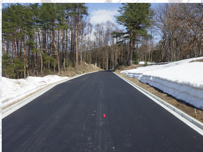
林道作設工事
