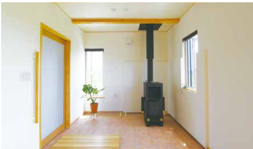
薪ストーブが設置された玄関土間。夏場は左側の引き戸を開けると玄関からリビングへ風が入る
