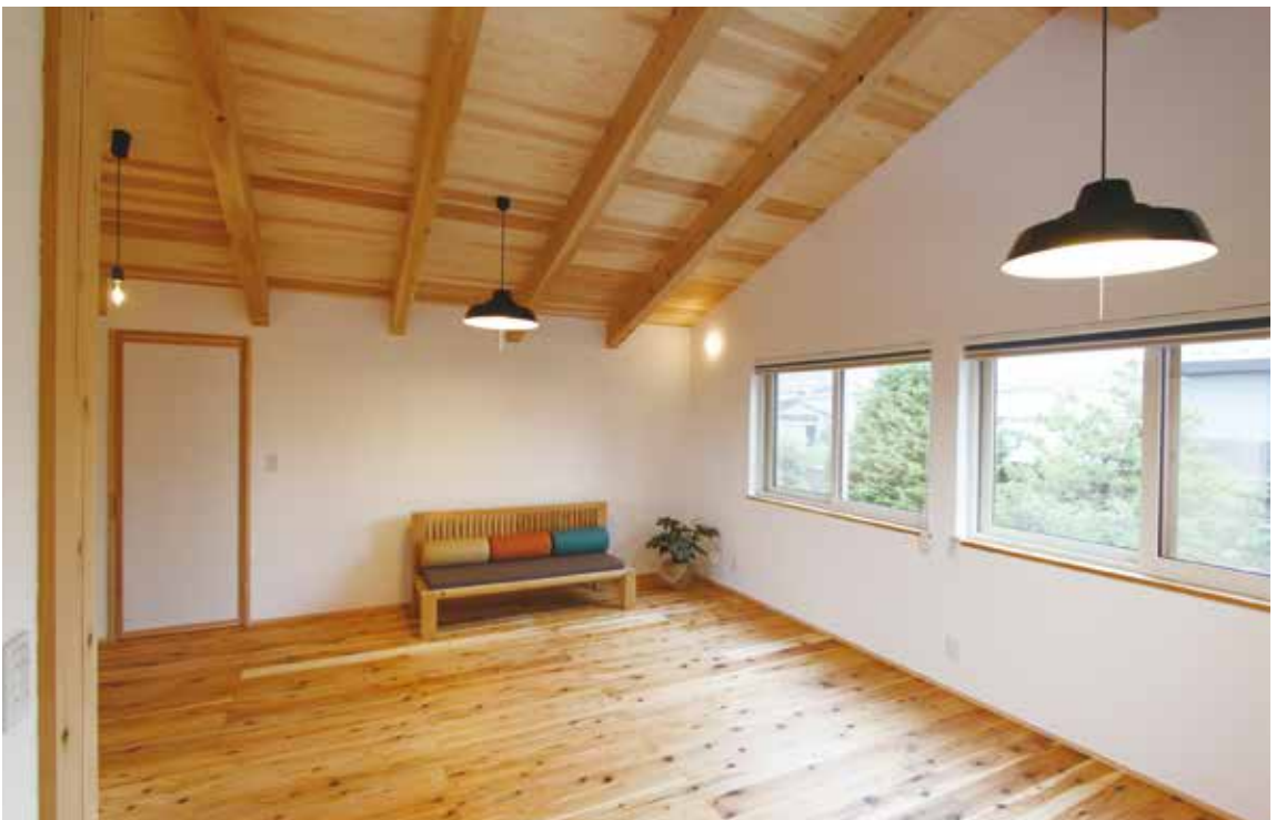
床には施主の要望で節のあるスギ板が使用されている
