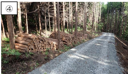
④ 丸太をトラックに積み込みやすい形に樅(はい)積みし、入札にかけます。落札した会社は、丸太を製材工場等へ運びます。
