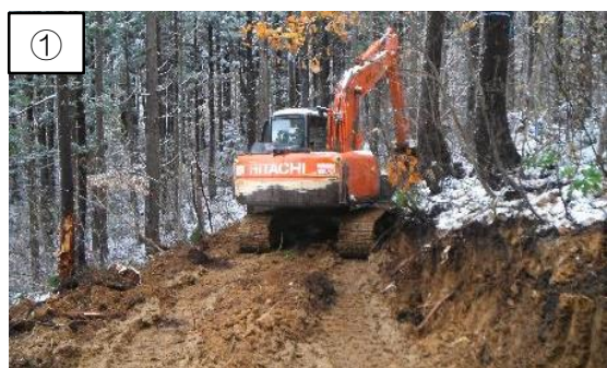
① 木材を搬出するために作業道を作ります。
