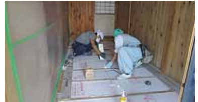
床下に断熱材を敷設(工事中)
