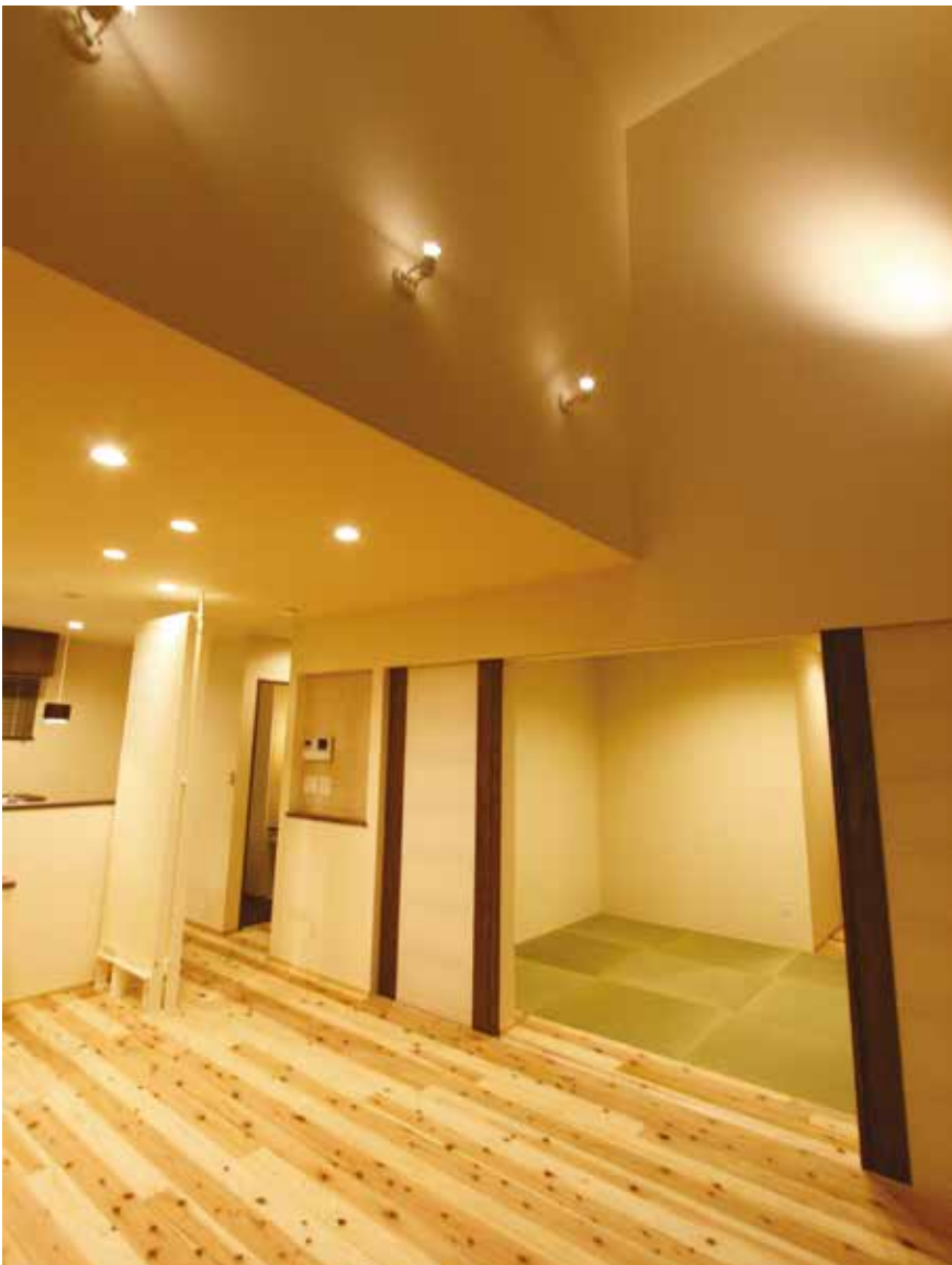
一部を吹き抜けにして採光を図った1階リビング
