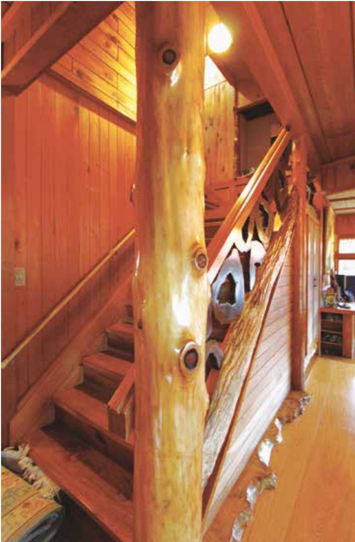
ヒバの丸太を生かした野趣に富む階段の造作
