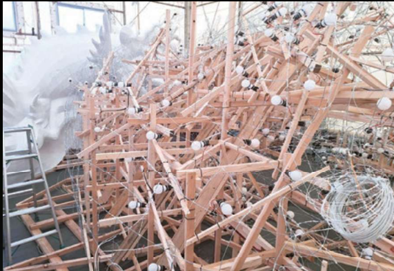
ねぶたの骨組み。木材は重量を支える重要な役割を担っている。
