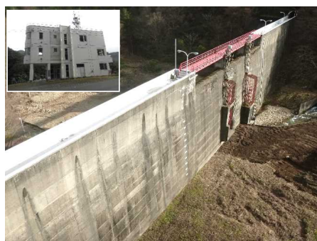
防災ダム事業 夏坂ダム地区（田子町、R3～R8） 防災ダムの施設改修
