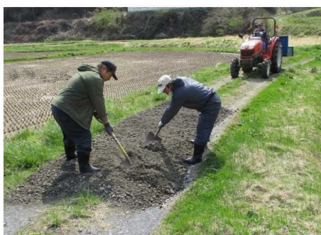
中山間地域等直接支払 ～農道へ砂利敷き～ (五戸町 荷軽井集落協定)
