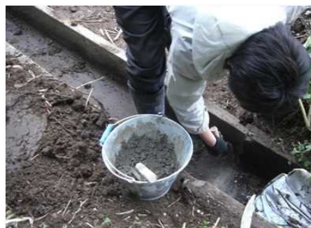
多面的機能支払 ～水路補修～ (田子町 上相米地区資源保全隊)
