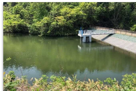
改修後のため池
