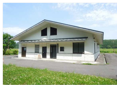
農業集落排水事業 石沢地区（五戸町、H5～H8） 農業集落排水処理施設の整備
