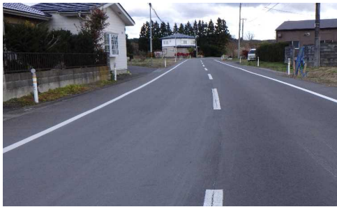
通作条件整備事業 館地区(八戸市、R3～R6) 基幹農道の路面改良
