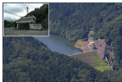
防災ダム事業 花木ダム地区（田子町、R4～R8） 防災ダムの施設改修（整備前）
