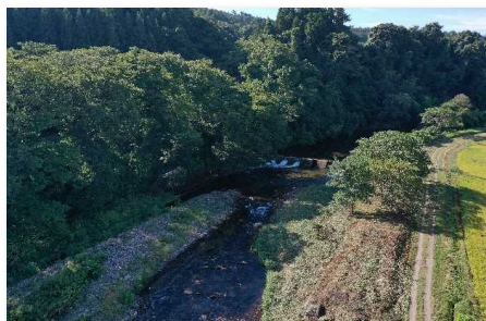
魚道整備前の舞手頭首工 （舞手地区：H29）
