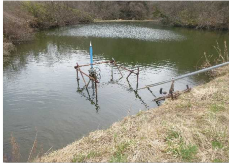
改修前のため池
