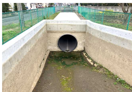
基幹水利施設ストックマネジメント事業 下長2期地区（八戸市、R3～R7） 農業用水路の改修
