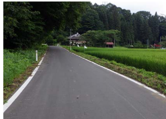
通作条件整備事業 川代地区（新郷村、R4～R8） 一般農道の路面改良
