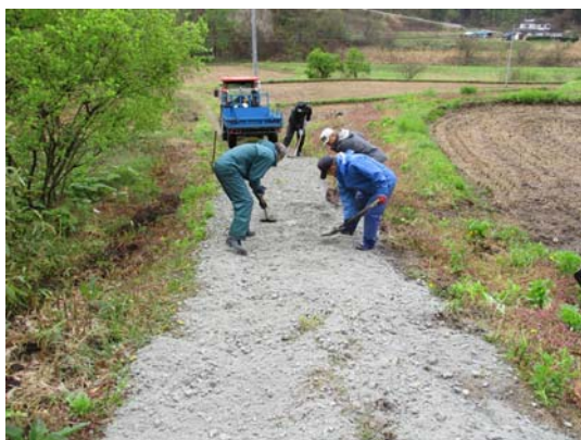
中山間地域等直接支払 ～農道へ砂利敷き～ (五戸町 荷軽井集落協定)
