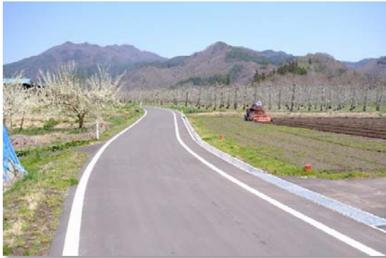
中山間地域総合整備事業 三戸地区（三戸町、H26～R6） 農道の整備
