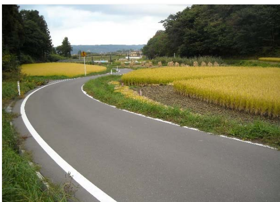
畑地帯総合整備事業 上名久井地区（南部町、H12～H21） 農道、農業用排水路等の整備
