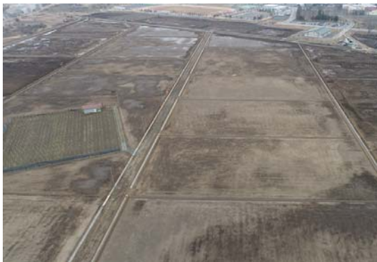
経営体育成基盤整備事業 名川第一工区地区（南部町、R3～R8） 区画整理工事後のほ場の様子
