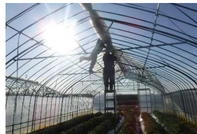
片付け（ビニールの撤去）
