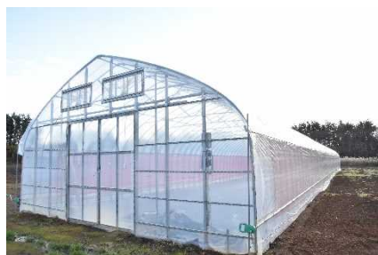
パイプハウス
