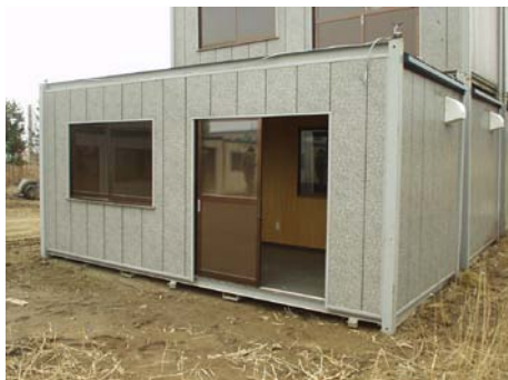
写真5 コンテナハウス（外観）
