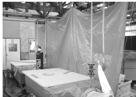
写真5 ブルーシートによる囲い
