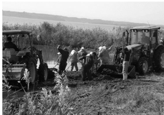
写真7 浮遊堆積物(水草等)除去作業
