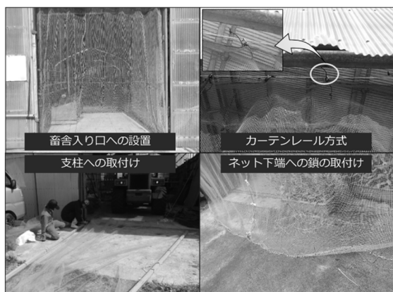
図4 防虫ネット設置状況
