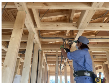
【木造住宅配線実習】
