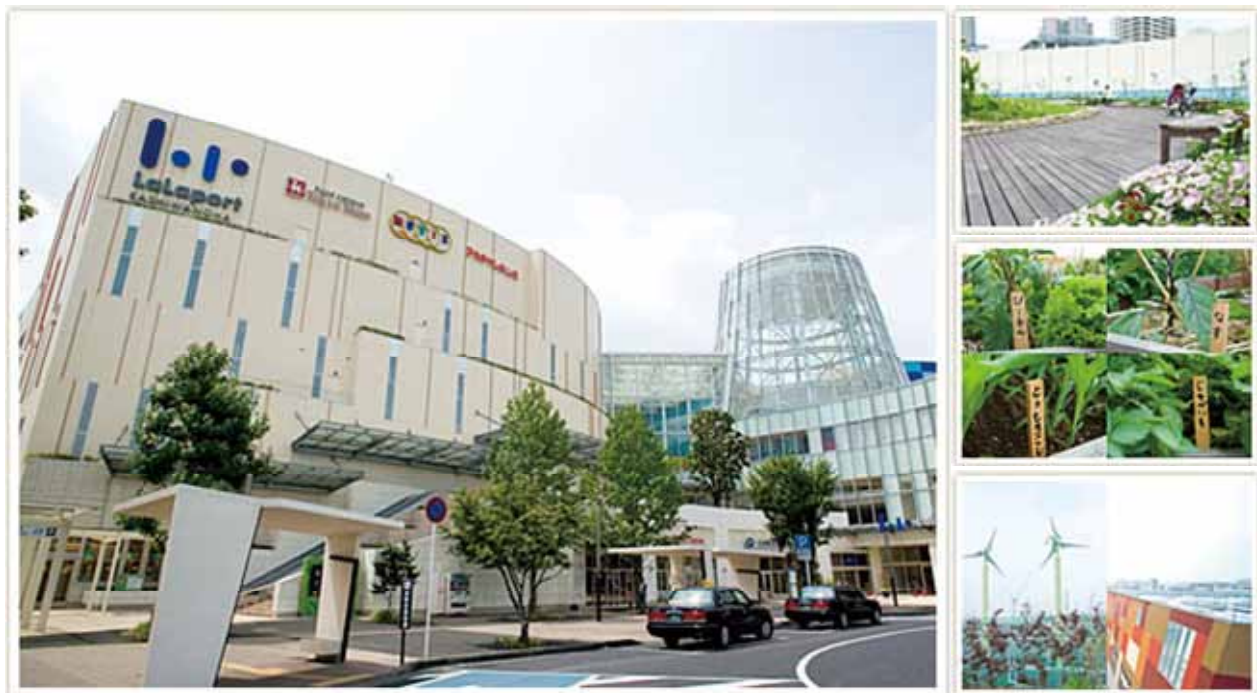
図 4-14 商業施設「ららぽーと柏の葉」と屋上庭園・農園、小型風力発電・太陽光発電設備
