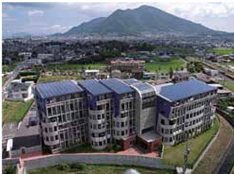
図4-34 太陽光発電システム付マンション「ニューガイア」(北九州市)
