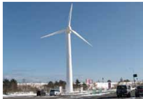
図4-26 イオンモール下田風力発電機
