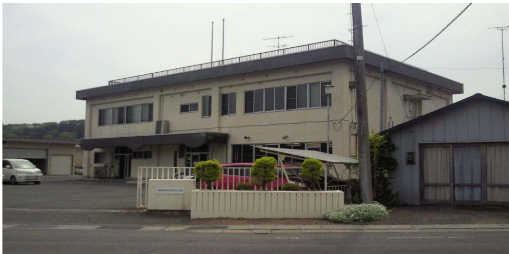
△建物全景(西側)
