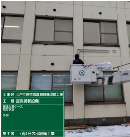
外部配管状況
