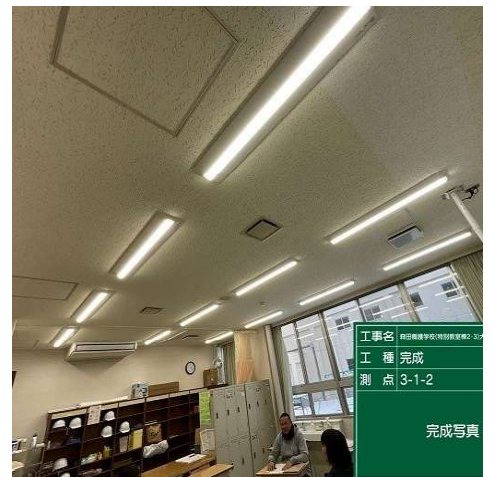
各教室LED照明に更新
