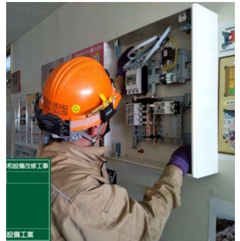
電気工事状況
