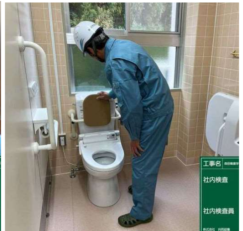
2階WC 衛生器具
