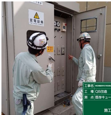
動力幹線（現場調査）
