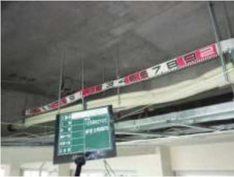
配管支持間隔 確認状況
