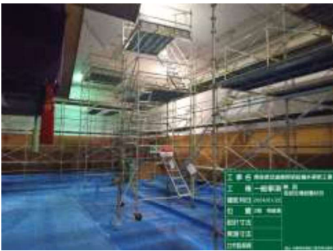
相撲場足場設置状況（施設使用制限作業）
