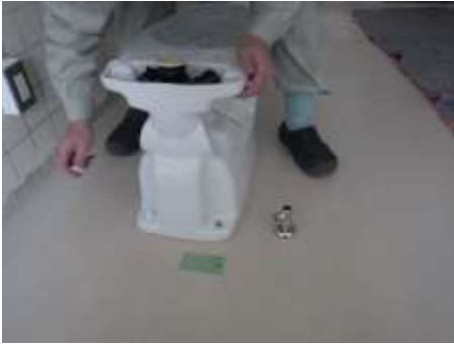
衛生器具 取付状況
