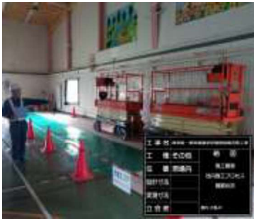
居ながら改修現場内における 作業エリアの区画状況
