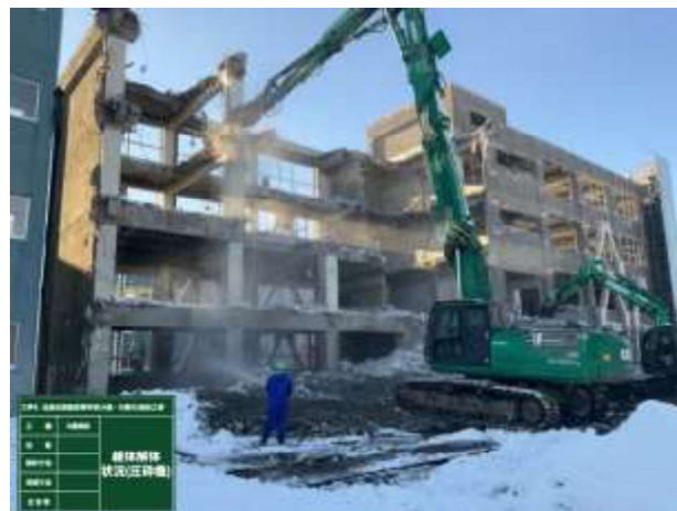
躯体解体状況
