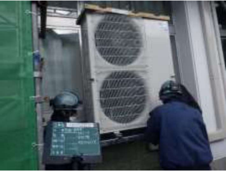
室外機 据付状況
