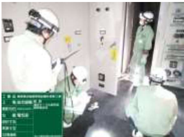
高圧ケーブル耐圧試験状況 （施設を休館させての停電作業）
