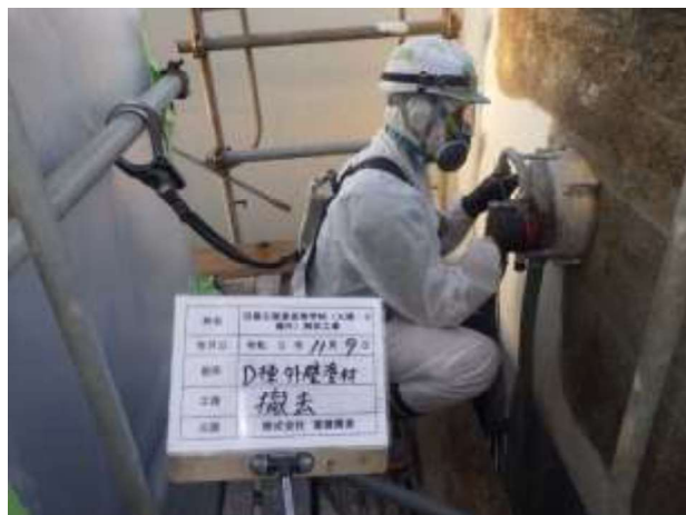
アスベスト除去状況
