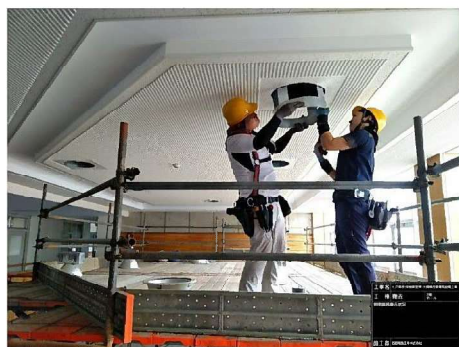
高天井用照明器具 撤去状況
