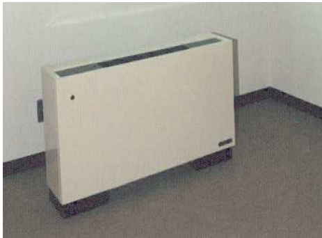
ファンコイルユニット
